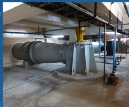
Wysokowydajne pompy do ścieków. Fot. J. Gawryłek
