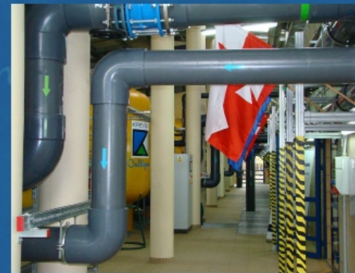
Uruchomienie SUW Królewiec w 2009 roku przebudowa. A.Z.
