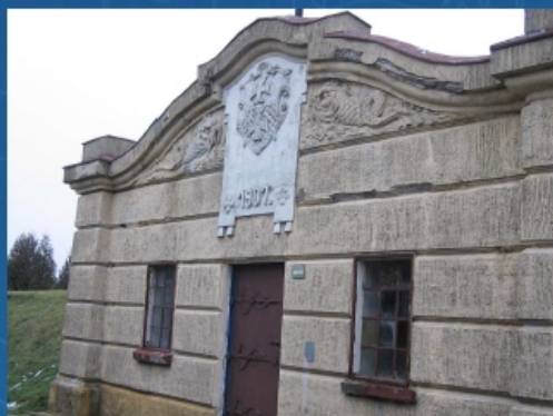
Budynki wodociągowe z początku XX wieku budowane były w Elblągu w stylu nawiązującym do antyku, a herb miasta podkreślał ich komunalny charakter. Na zdjęciu stan z 2007 roku. Fot. I. Leszczyński
