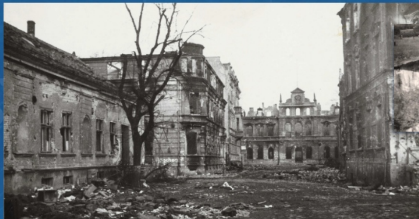
Zniszczone i spalone centrum Elbląga w 1945 roku. Widok na ulicę Krótką. AA
