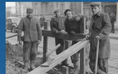
Prace przy naprawie awarii na ulicy 1 Maja. AZ
