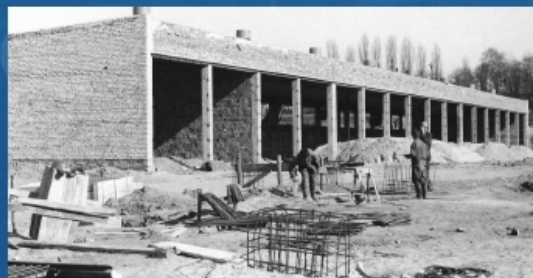
Budowa nowej siedziby firmy przy ulicy Rawskiej - na zdjęciu pawilon garażowy w marcu 1974 roku. AZ
