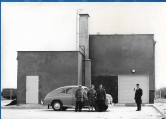
Stacja Uzdatniania Wody Malborska została zbudowana w 1966 roku. AZ
