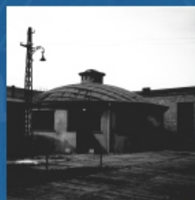
Przepompownia ścieków ulokowana została przy ulicy Browarnej. AZ
