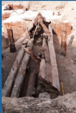
Wschodni odcinek elbląskiego wodociągu usytuowany nad fosą. Słupy stanowią pozostałość mostu. (Obecnie Plac Słowiański)
