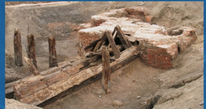
Wschodni odcinek elbląskiego wodociągu usytuowany nad fosą, umieszczony w drewnianym zadaszonym korcie. Słupy stanowią pozostałość mostu. (Obecnie Plac Słowiański)
