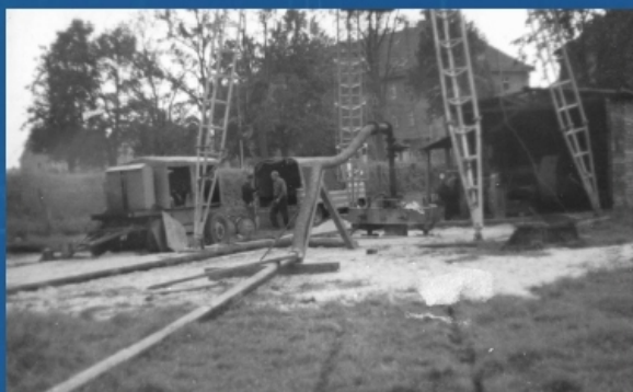
Budowa studni Nr 3a przy ulicy Łączyczej w 1968 roku. AZ
