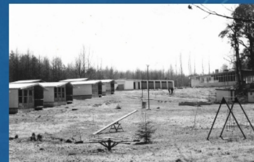
Ośrodek wypoczynkowy wodociągowców w Liksajnach zbudowano własnymi siłami w latach 1972-1973. AZ
