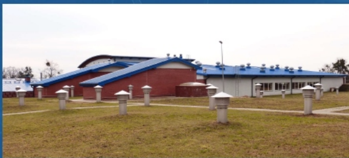
SUW Królewiec - widok na zmodernizowane obiekty. Fot. J. Gawryłek
